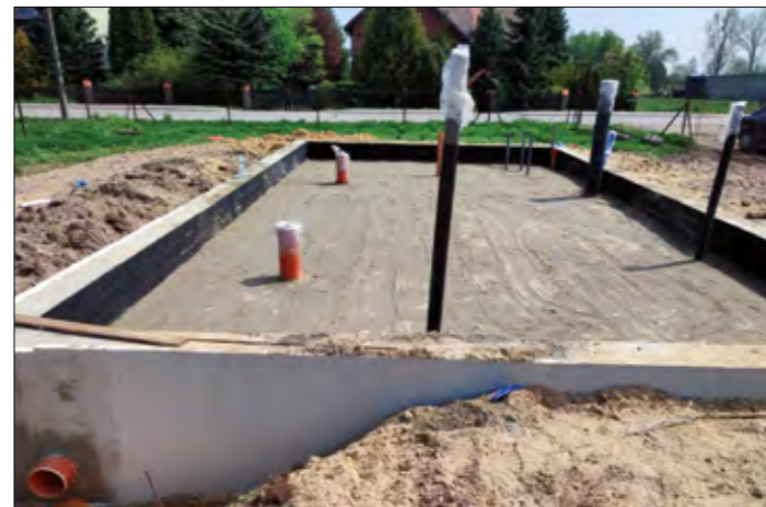
fol. Budowa SUW w Dąbrowicach
