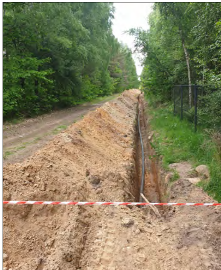
fol. Budowa wodociągu w Świętem
