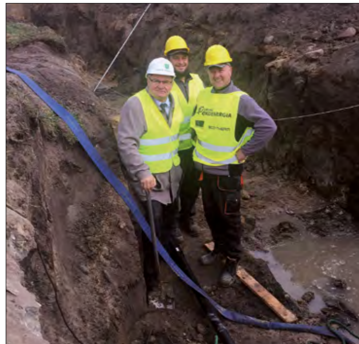
Na placu budowy Urzędu Gminy
